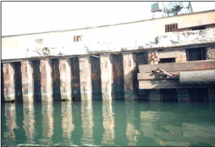
Рис. 1.4 Крепление ОУ из Д400 на место деревянной рамы (видны остатки уголков)
