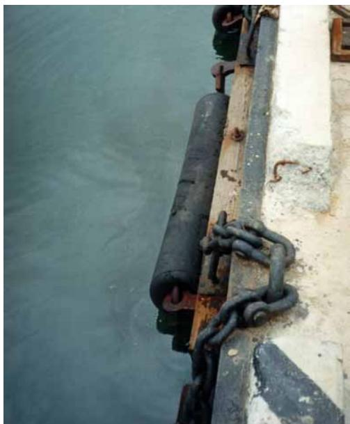
Рис. 1.7 ОУ из Д400 с U-образным соединительным болтом
