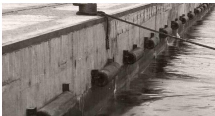
Рис. 1.5 Жесткое крепление цилиндров Д400
